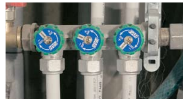
△ Коллектор со встроенными шаровыми кранами на три линии
